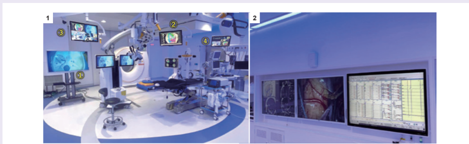
図7 (1) 第一手術室内における映像の出力先。①外回り医師用、②術者用、③直接介助看護師用、④麻酔科医用の4種類がある。部屋の奥にはCTが見える。(2) CTの対面にあたる壁面には大画面モニターが3枚設置されている。右端のモニターにはMEP・SEPの術中電気生理モニタリングの波形が出ているが、映像コントロール画面と切り替わる。
