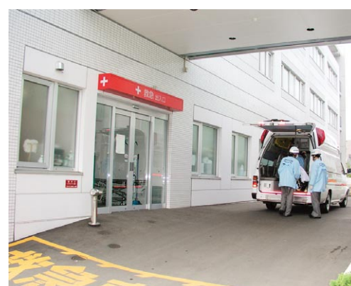
国道36号から直接 乗り入れられる救急 車専用通路
